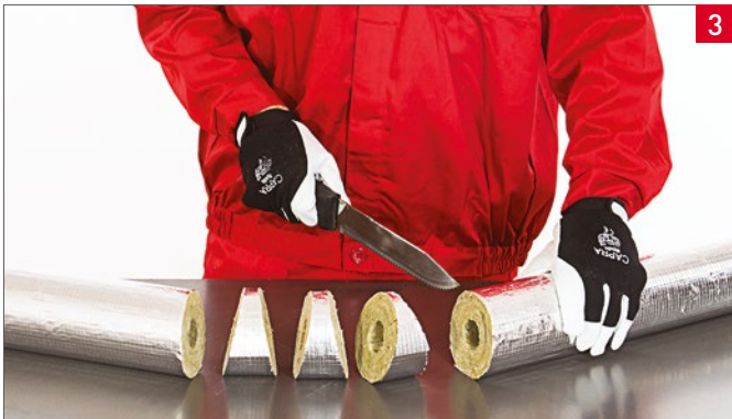
3 Ukázka řezání jednotlivých segmentů kolen
