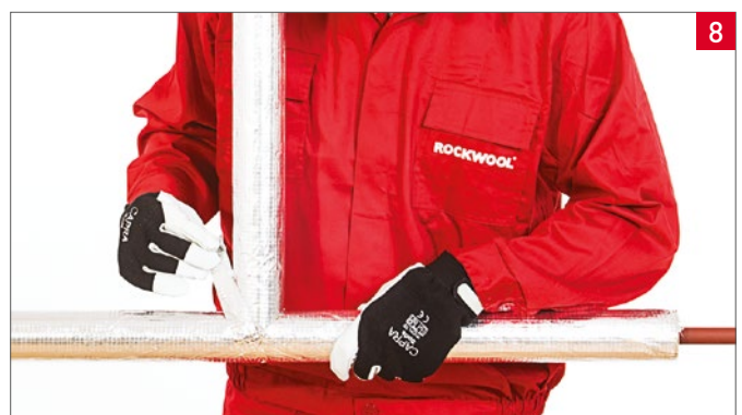
8 Přelepení spojů hliníkovou páskou
