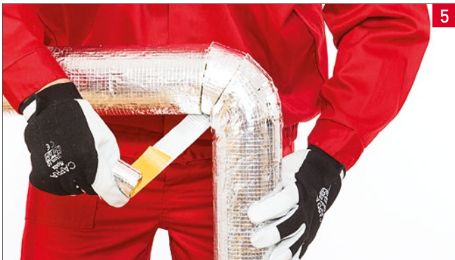
5 Přelepení spojů kolena hliníkovou páskou
