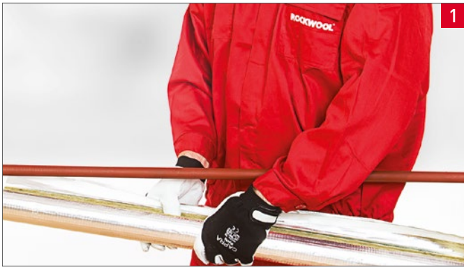
1 Snadné nasazení pouzdra na potrubí
